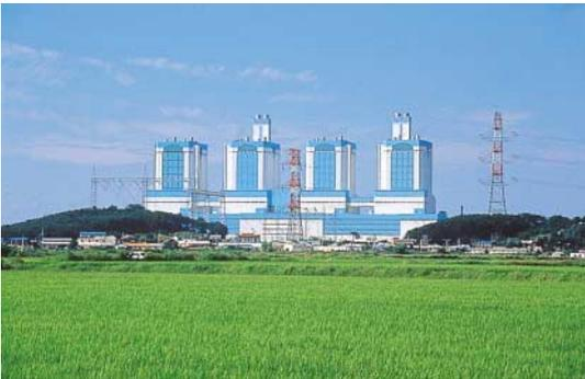
물의 힘 대신 원유나 중유 등을 연료로 하여 보일러로 증기를 발생시킨 다음, 그 압력으로 터빈에 연결된 발전기를 돌려 전기 에너지로 바꾸는 곳이다. 연료로 사용하는 석유 등을 해외에서 운반해 오기 때문에, 화력 발전소는 수송이 편리하고 운전이 필요한 대량의 물을 얻기 쉬운 해안가에 만들어진다.
