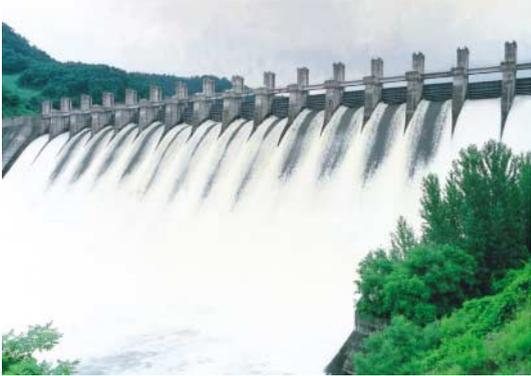
높은 곳에 있는 물을 낮은 곳으로 유도하여, 물이 떨어지는 힘, 즉 물이 가지고 있는 위치에너지를 운동 에너지로 바꿔 수차를 돌리고, 발전기는 수차의 운동 에너지를 전기 에너지로 바꾼다. 수력 발전소는 일반적으로 험한 산속에 건설되어 전기 소비지에서 멀리 떨어져 있기 때문에, 송전선이나 댐 등의 건설에 많은 비용과 시간을 필요로 한다. 발전에 이용할 수 있는 물의 에너지는 낙차와 물이 흐르는 양의 곱에 비례한다.
